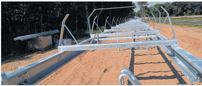
Entlang der Straße wird das Förderband installiert.
